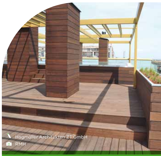
Bâtiment résidentiel Braunhubergasse 28 (1580 m 2 ) Vienne, Autriche
